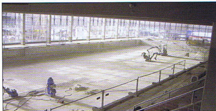
Die Renovierung des Europabades verzögert sich.
