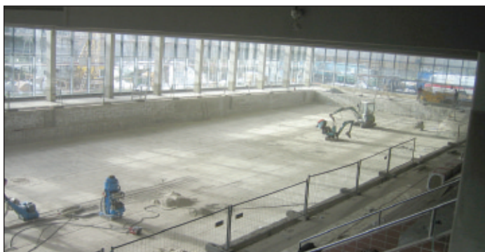
Die Renovierung des Europabades verzögert sich.
